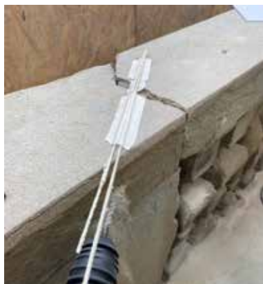
Fasi di posa delle barre in carbonio.
