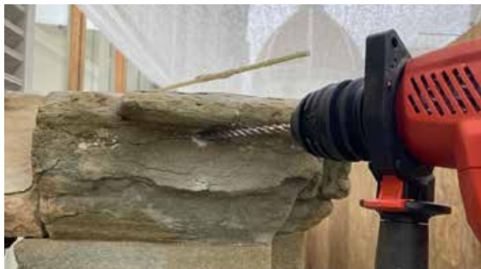
Fasi di posa delle barre in carbonio.
